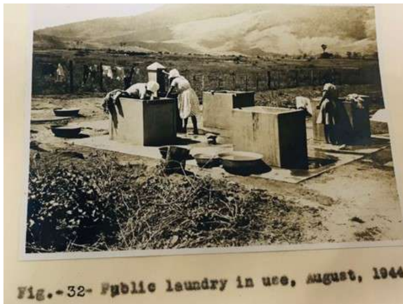
Figura 6 - Lavanderia construída pelo Serviço Especial de Saúde Pública (SESP)
