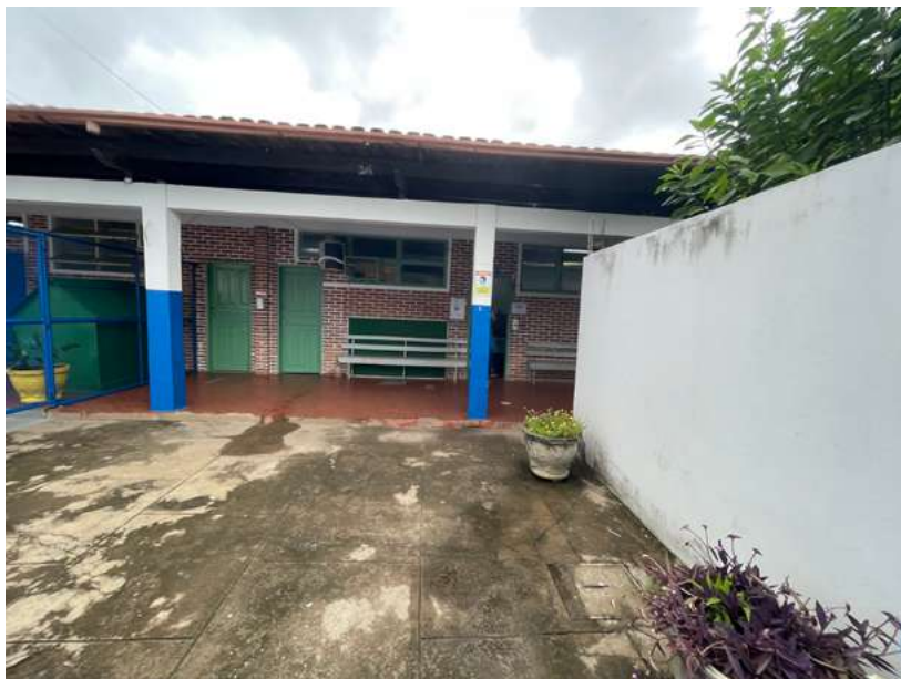
Figura 4 – Vista interna da escola, parte integrante da ESF
