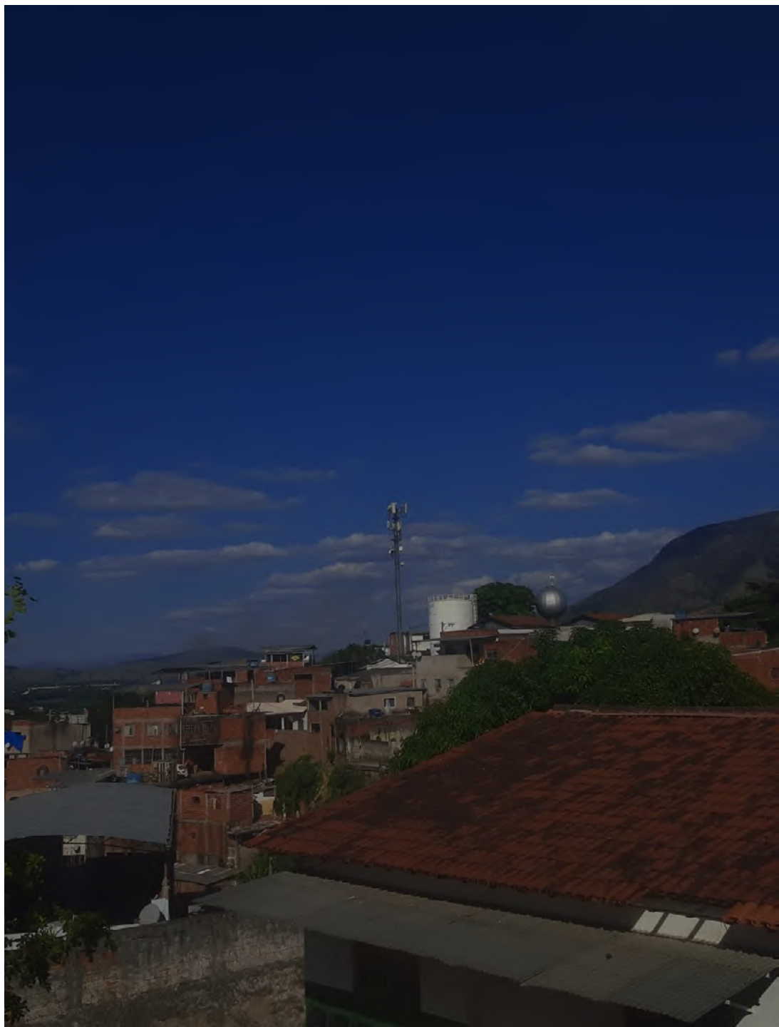
Foto 1 – Telhado da sala de balé Autoria: Evellyn Oliveira da Silva (2023)
