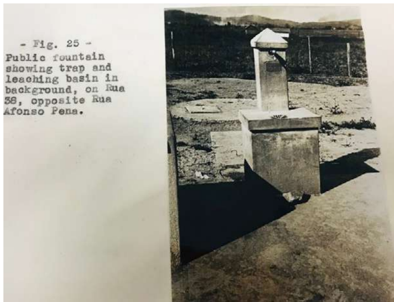
Figura 5 - Chafariz construído pelo Serviço Especial de Saúde Pública (SESP)
