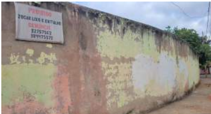
Figura 6 – Condições da infraestrutura do bairro Turmalina
