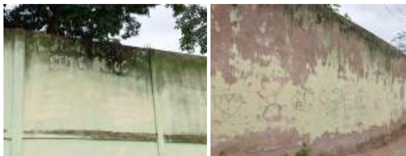
Figura 1 – Muro da escola
